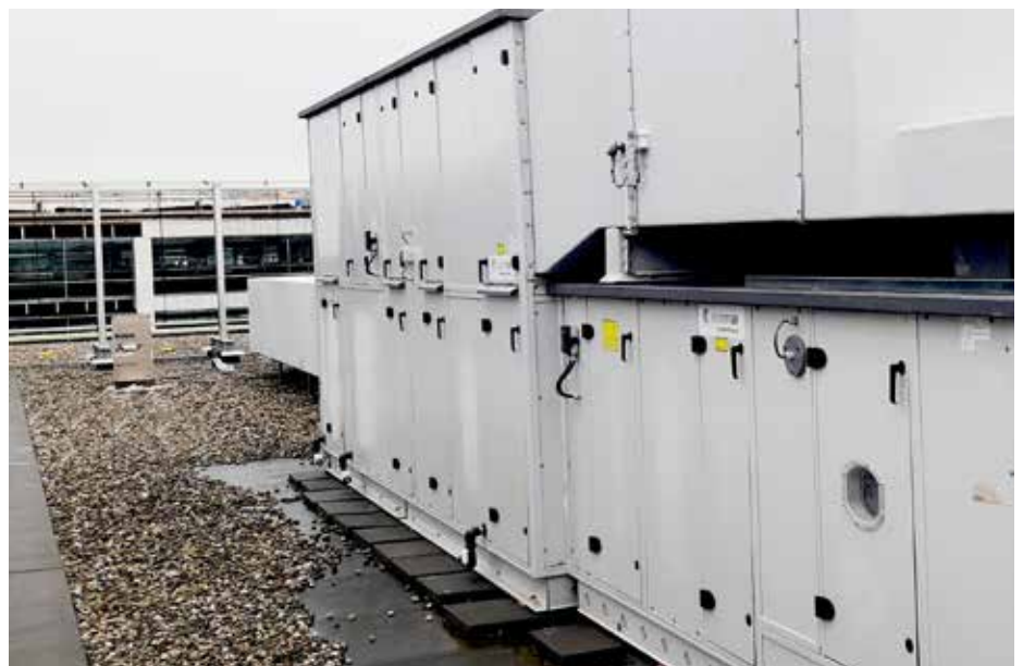
Inmiddels zijn alle luchtbehandelingsunits naar Hoofddorp vervoerd en op het dak geplaatst.
